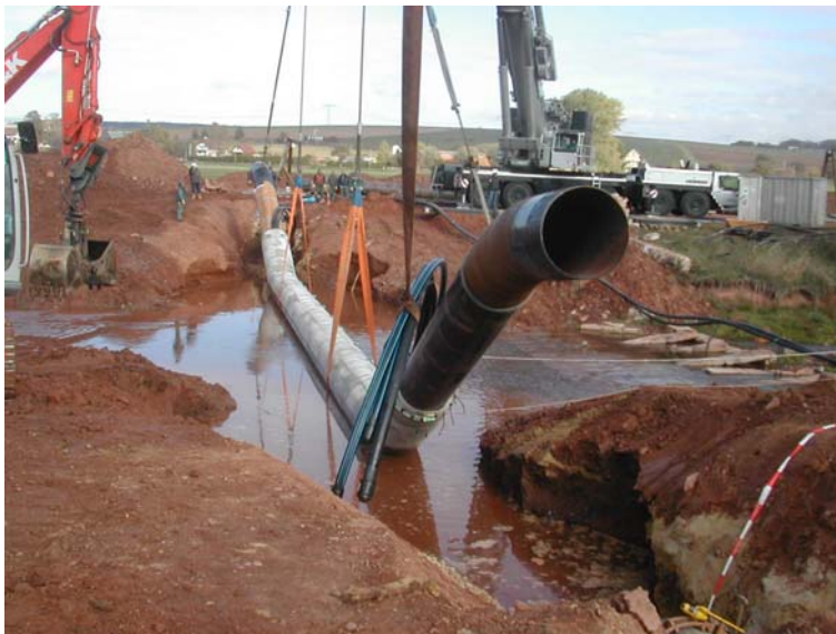
Abbildung 3: Einheben eines Dükers
