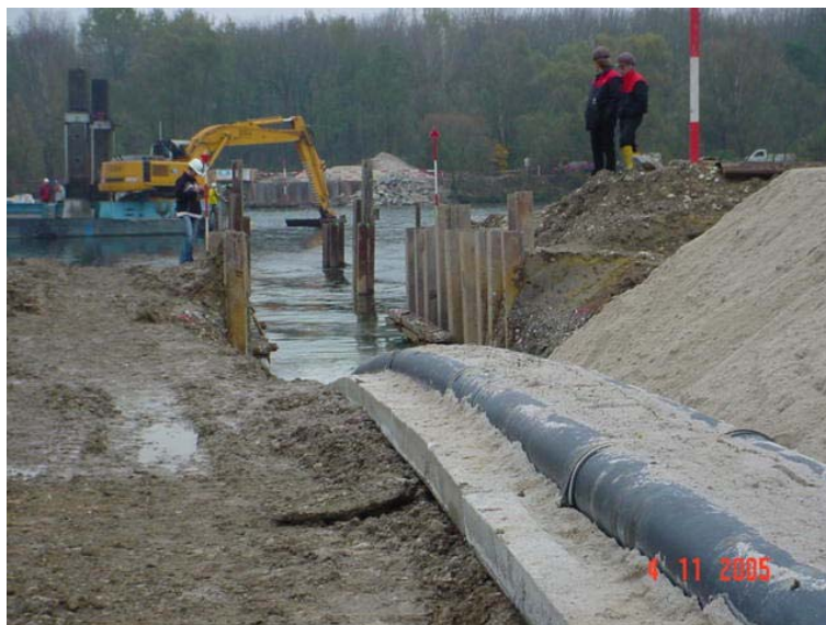
Abbildung 1: Einziehverfahren (bottom-pull)
