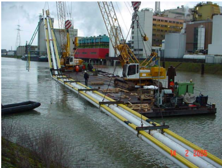
Abbildung 2: Einschwimmen eines Dükers
